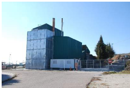
Central térmica Cuéllar
